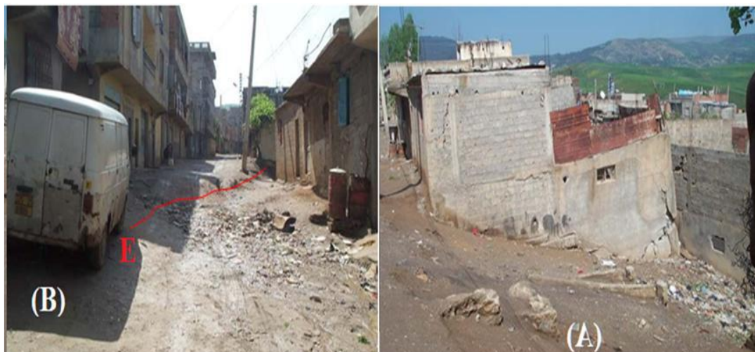
Fig. 25 : Glissement du quartier de Boudraa Constantine [BOU, 2007]
