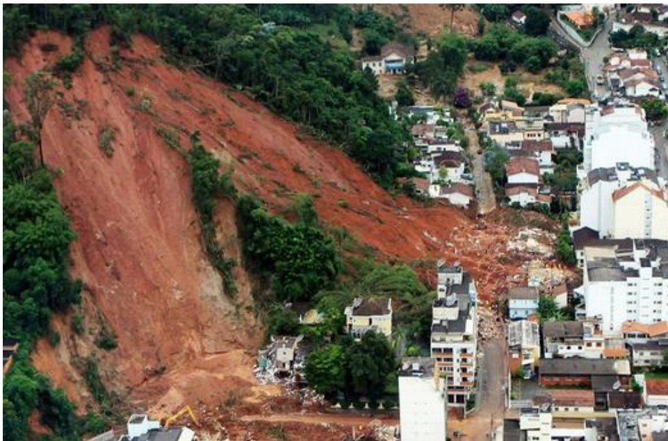
Fig. 9 : Exemple de glissement de terrain (Rio de Janeiro, Brazil, 2013)
