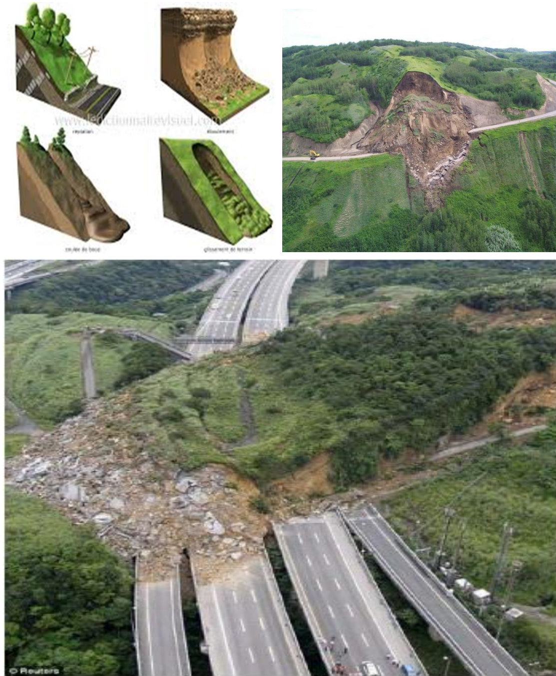
Fig. 24 : Quelques images sur les glissements de terrain [Divers site internet]
